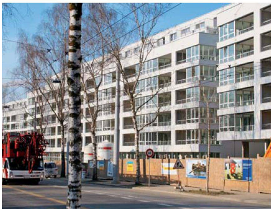
Affoltern erlebte 2007 einen Neubauboom. Im Bild das CeCe-Areal, wo Investor Leopold Bachmann über 500 Wohnungen erstellte.
