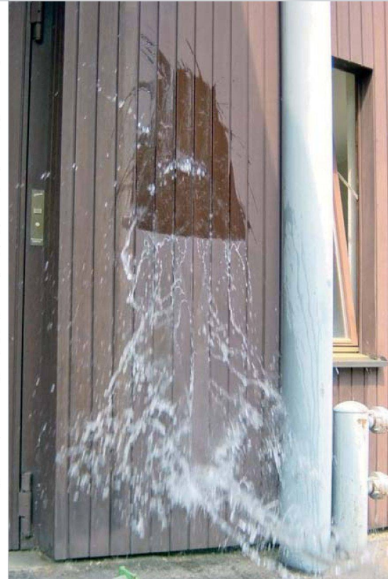
Mit einer Nanobeschichtung lassen sich Holzfassaden vor Feuchtigkeit schützen.
