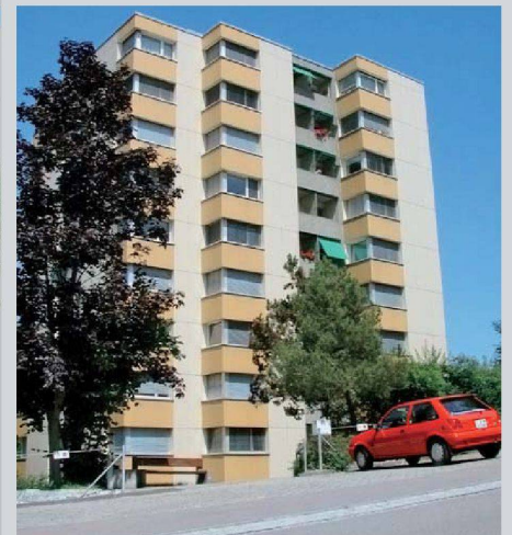
Der Bestand der Baugenossenschaft für schönes Wohnen umfasst Wohnblöcke mit Familienwohnungen sowie zwei Hochhäuser mit Kleinwohnungen für Senioren und Studenten.
