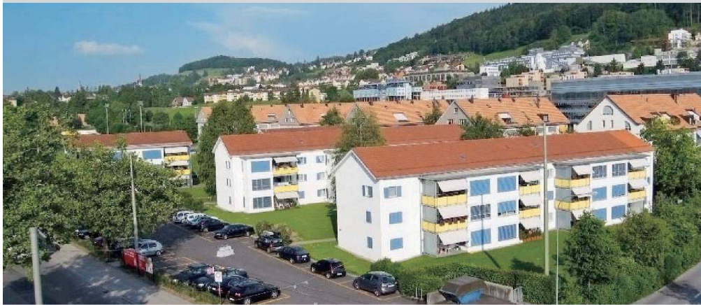
Die erste Siedlung von 1960 wurde in den Jahren 2004–06 total saniert, die Grundrisse erweitert.
