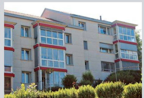
Ihre zwei jüngeren Baulose hat die EBG innen und aussen saniert. Dabei erhielten die Wohnungen grosszügige verglaste Balkone.
