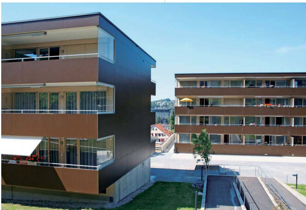
Die im vergangenen Jahr bezogene zweite Etappe im Linsebüelgut umfasst zwei Bauten mit dreissig Wohnungen.
