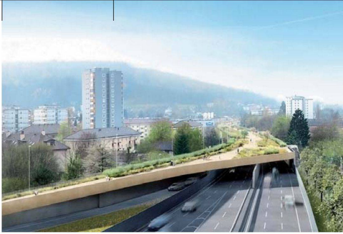
Visualisierung der geplanten Autobahneinhausung in Zürich Schwamendingen.
