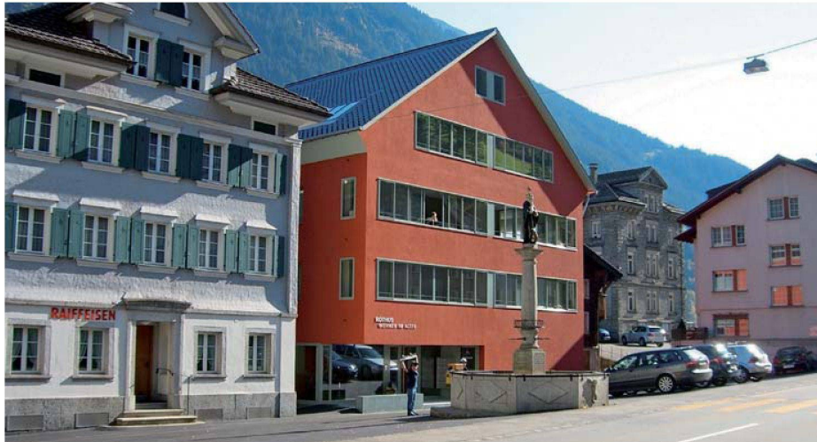
Moderne Alterswohnungen bietet das neuerstellte Rothus am Dorfplatz von Wassen (UR).
