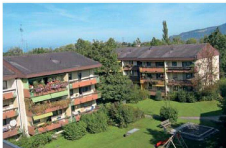
Die Überbauung Fussenau der Vogewosi aus dem Jahr 1980 verbrauchte pro Quadratmeter und Jahr 250 Kilowattstunden Energie. Diesen Bedarf galt es um den Faktor 10 zu verringern.
