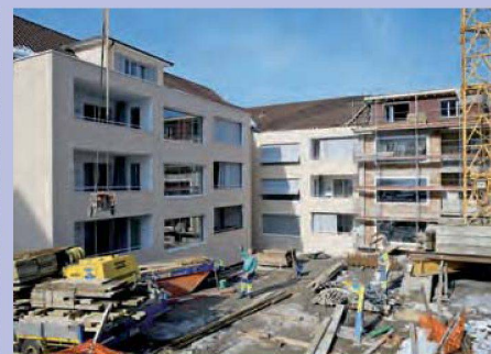
Auf der Hinterseite des Z-Blocks durften Anbauten und neue Balkone erstellt werden.
