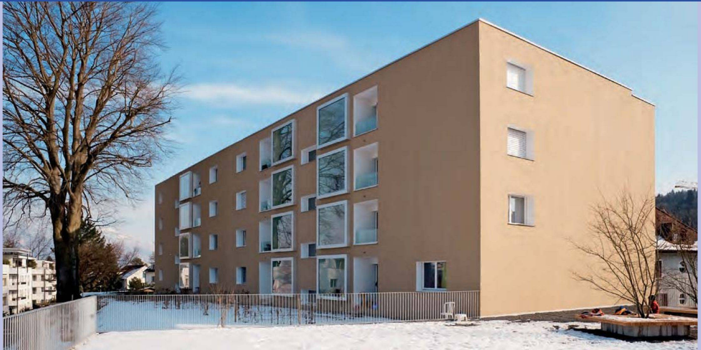
Am Höhenweg erneuerte die EBG Luzern einen 1960er-Jahr-Bau umfassend. Auf der Nordseite ergänzte man die Wohnungen mit grossflächigen Kastenfenstern.
