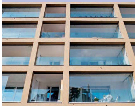
Die vergrösserten Balkone, die sich dank faltbaren Glasteilen in Wintergärten verwandeln lassen, prägen die Südfassade.
