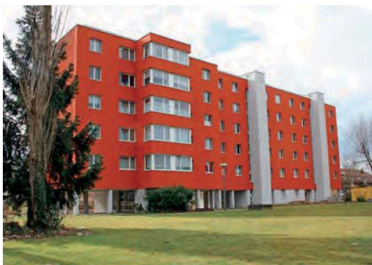
Die beiden Hochhäuser erhielten Küchenanbauten (links).
