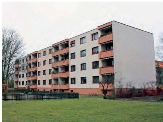
Keinen dringenden Investitionsbedarf ortete der Energiecoach bei dieser Liegenschaft am Zeglingerweg in Basel. Jetzt klärt der Vorstand der Bau- & Wohn-genossenschaft Singerhof ab, welche Massnahmen längerfristig sinnvoll wären.
