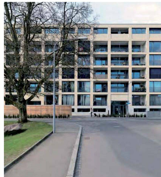
Unterschiedliche Pfeilerabstände rhythmisieren die Fassade aus Kunststein.
