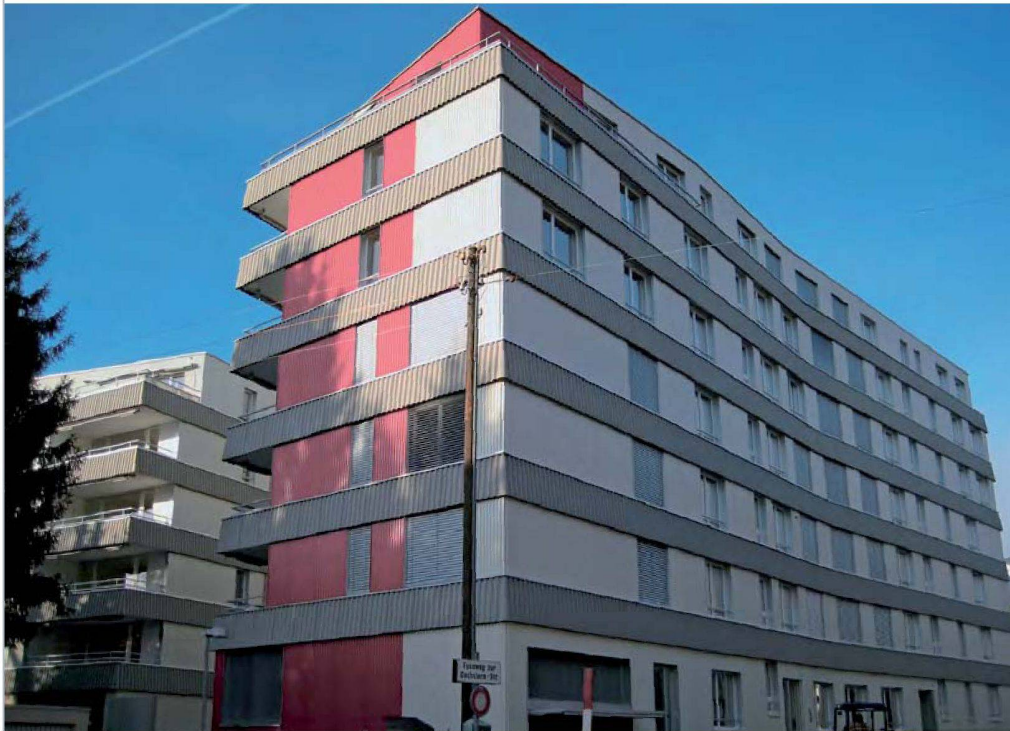
Der Querbau bildet einen Lärmriegel gegen die Farbhofstrasse und setzt im Quartier einen kräftigen roten Akzent. Ein leicht ausgestelltes Wellelternitband säumt die Fassade.
