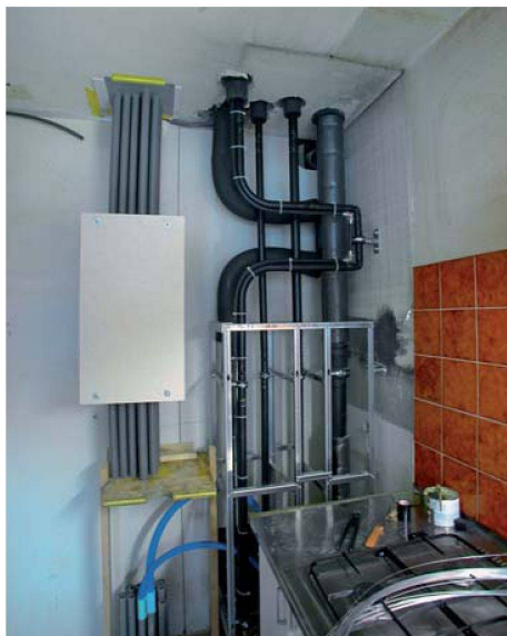
Da die alten Leitungen einbetoniert waren, mussten neue Steigzonen geschaffen werden.
