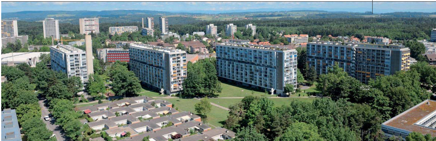
Das Hochhaus Schwabstrasse 70/72 gehört zum Schwabgut-Ensemble mit insgesamt 1100 Wohnungen. Blick vom Dach auf weitere Schwabgut-Bauten.
