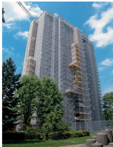
Hohe Anforderungen stellte auch die Logistik auf der Baustelle.
