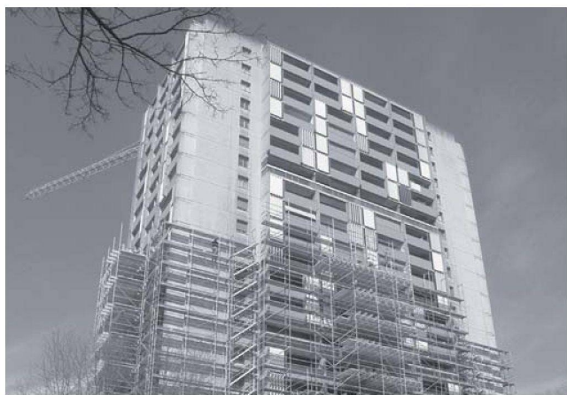
Gesamterneuerung Hochhaus mit 120 Wohnungen im Schwabgut Bern
