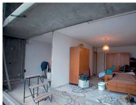
Ungewohnte Wohnsituation beim Einbau der neuen Fenster.
