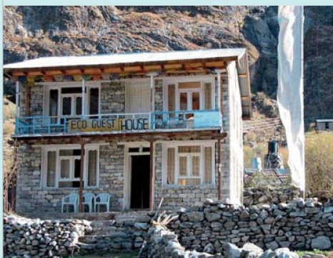
«Eco Guest House» an der Langtang-Trekkingroute mit Solarpanels für «Hot-Showers».
