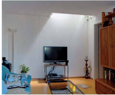
Öffnungen in der Decke führen das Licht sowohl in den ersten Stock als auch in den Wohnbereich im Erdgeschoss (siehe auch Titelseite).
