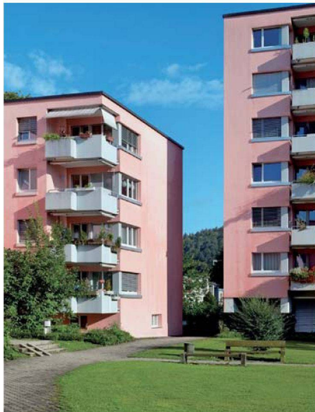
Die Totalsanierung von 128 bewohnten Wohnungen erforderte eine straffe Planung. Die Arbeiten in den Wohnungen wurden strangweise durchgeführt, pro Strang standen vier Wochen zur Verfügung.
