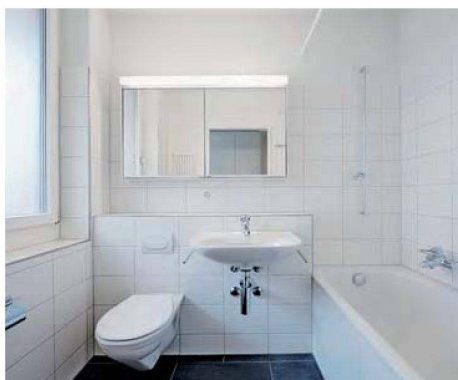
Blick in das neue Bad. Die Installationen sind in einem Vorwandssystem untergebracht.
