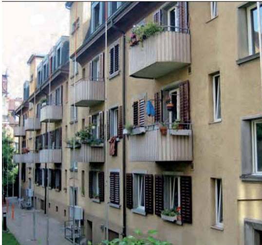
So präsentierten sich die Hoffassaden vor der Erneuerung.
