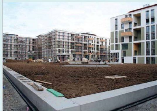
Blick in den Innenhof der Siedlung «Klee».
