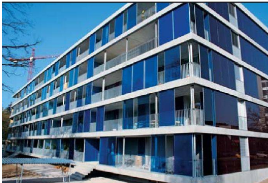
Gutes Raumklima für Grossfamilien: Die Stiftung Wohnungen für kinderreiche Familien setzte bei ihrer Siedlung Brunnenhof in Zürich auf Minergie-Eco.
