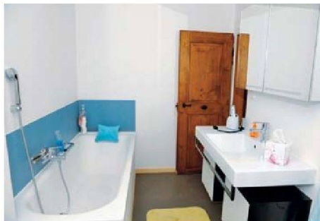
Auch die Bäder mussten ersetzt werden – die Tür blieb erhalten.
