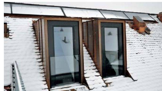
Oberhalb der Dachgauben befinden sich unauffällig integrierte Sonnenkollektoren.
