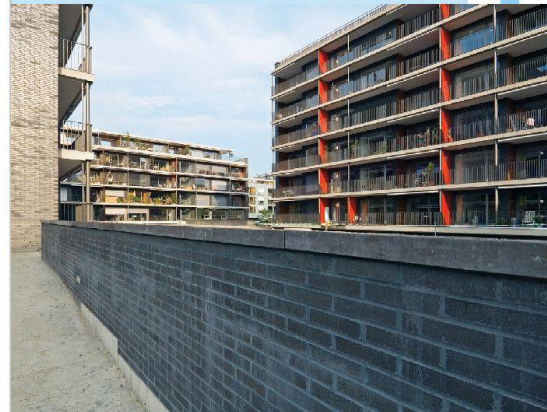
Die Luzerner Baugenossenschaften sollen bei städtischen Entwicklungsschwerpunkten stärker zum Zug kommen. Das fordert das G-Net, ein Zusammenschluss von Luzerner Genossenschaften. Chancen für eine genossenschaftliche Beteiligung gibt es durchaus, wie das Beispiel der erfolgreichen Neubauesiedlung Tribschentstadt der ABL zeigt.
