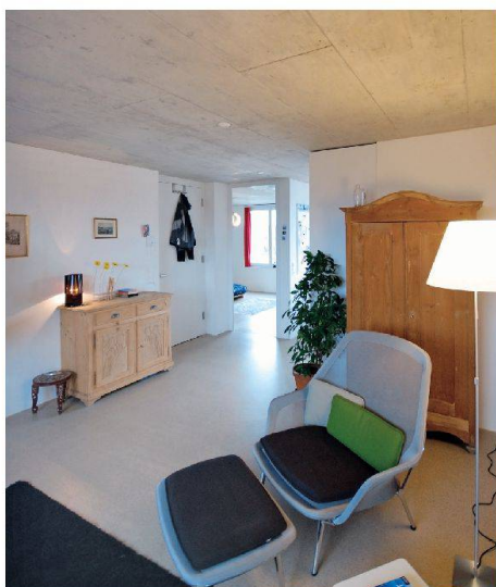
Anhydrit wird als Fließbelag aufgebracht. Da der Boden keine Fugen hat, ist er besonders leicht zu pflegen. Kosten konnte man im Neubau Grüngasse der Wogono Zürich (Bild) jedoch nicht sparen.
