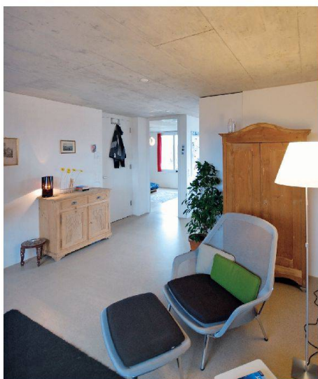
Anhydrit wird als Fließbelag aufgebracht. Da der Boden keine Fugen hat, ist er besonders leicht zu pflegen. Kosten konnte man im Neubau Grüngasse der Wogeno Zürich (Bild) jedoch nicht sparen.
