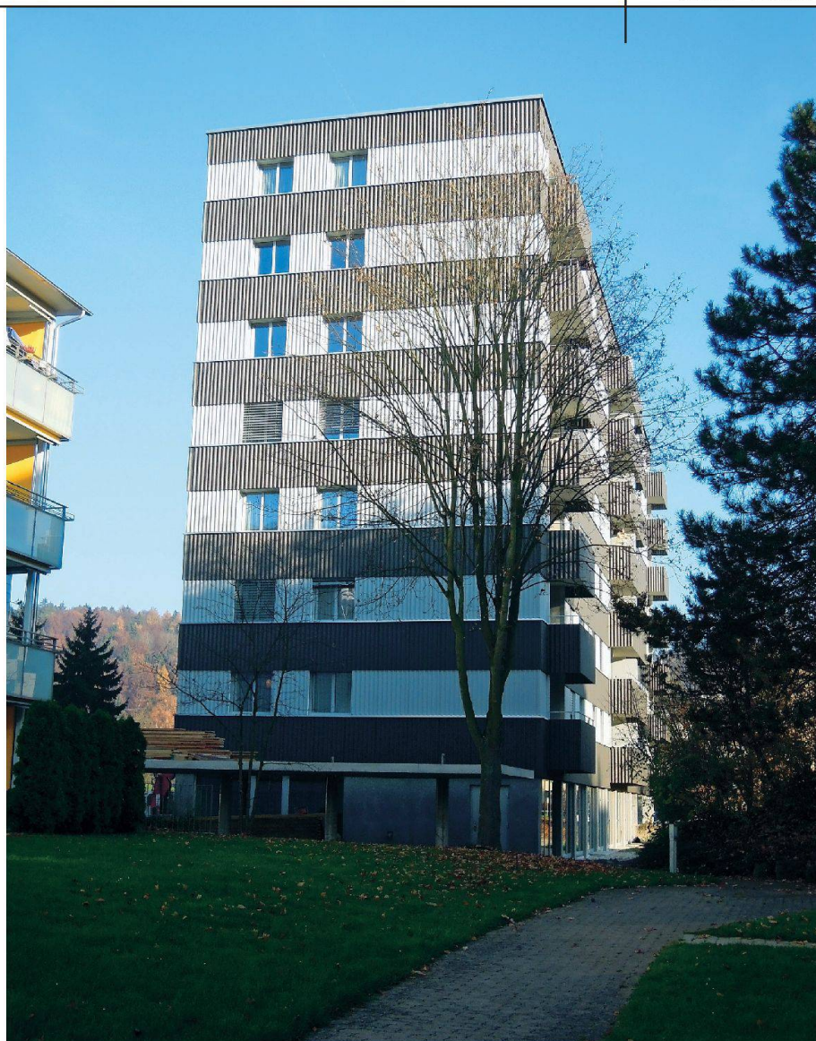
Die Eternitplatten prägen das Erscheinungsbild.
