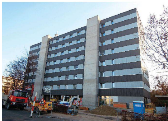
Blick auf die Eingangsseite.
