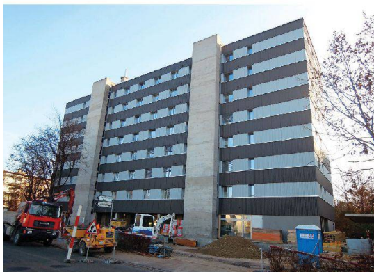
Blick auf die Eingangsseite.
