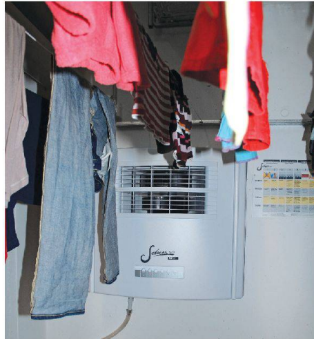
Raumlufttrockner behandeln die Wäsche schonender als Tumbler, die Trocknungszeit ist jedoch dreimal länger.
