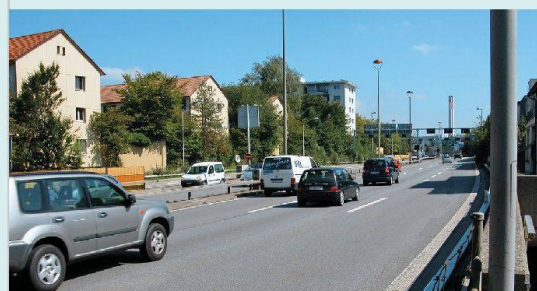
So präsentiert sich die Situation heute: Die Autobahn durchschneidet das Quartier Saatlén. Bis die «Einhausung» Abhilfe schafft, wird es jedoch noch dauern.
