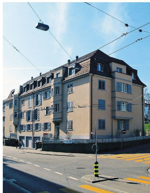
Eingangsseite (Mutschellenstrasse): Dank schallisolierten Fenstern bleibt der Lärm draussen.
