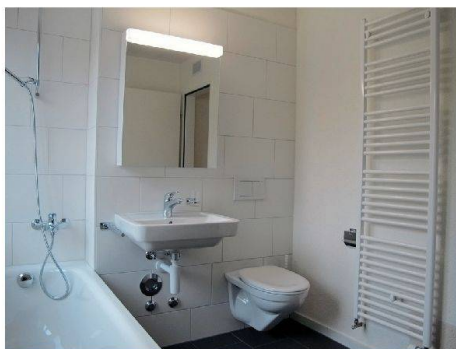
Auch die Bäder wurden rundum erneuert.
