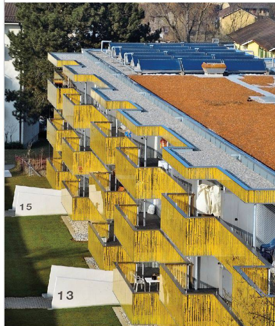
Gemäss BGM-Strategie haben alle Häuser Solaranlagen erhalten (Blick auf Heumatt 2).
