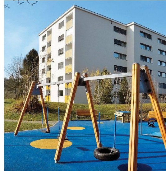
Die Gebäudehüllen wurden gedämmt, die Fenster erneuert.
