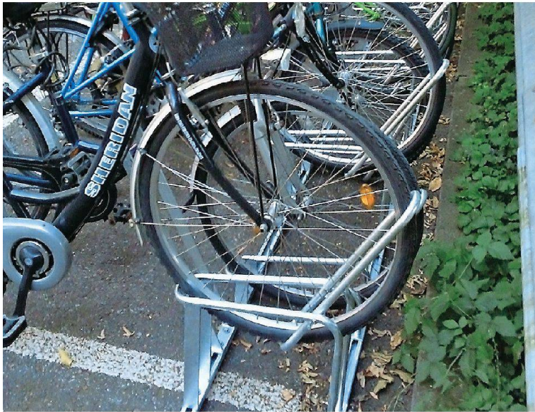
Bei diesen Veloständern des Typs «Virola» sind die Velos sehr gut positioniert und fixiert (Real AG, Thun).
