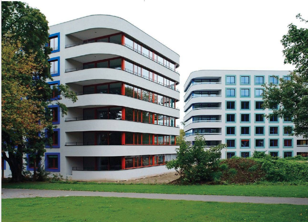
Jeder Bau hat sein eigenes Farbkonzept. Der grosszügige Grünraum blieb weitgehend erhalten.
