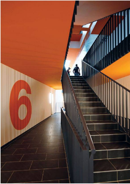
Die kompakte Bauweise verlangte ein innenliegendes Treppenhaus. Dank einer Schachttöffnung, Farbtupfern und dem speziellen Grundriss wirkt dieses dennoch freundlich.
