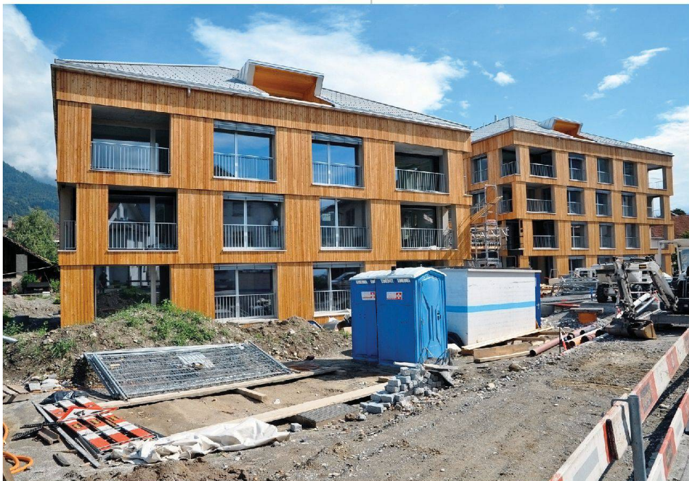
Grosse Fensterflächen fangen die passive Sonnenwärme ein. Zwischen den Bauten ist der Gemeinschaftsraum angeordnet.
