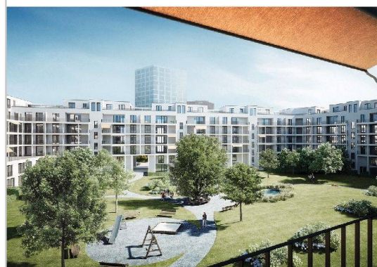
Das Richti-Quartier in Wallisellen ist die erste Arealüberbauung der Schweiz, die den Kriterien der 2000-Watt-Gesellschaft entspricht. Allreal erstellt hier Wohnraum für 1200 Menschen und 3000 Arbeitsplätze.
