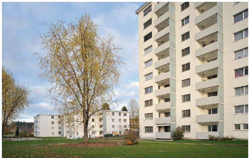
Die Siedlung im Waldhofquartier besteht aus sechs Wohnblöcken mit insgesamt 182 Wohnungen.
