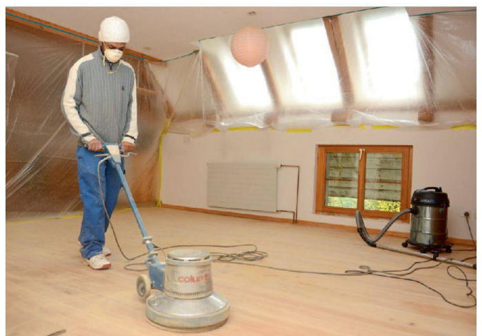
Instandsetzungsarbeiten übernehmen die Bewohner selbst.
