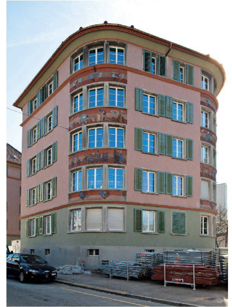
Der markante Kopfbau an der Ecke Erna-/Sihlfeldstrasse ist bereits erneuert.
