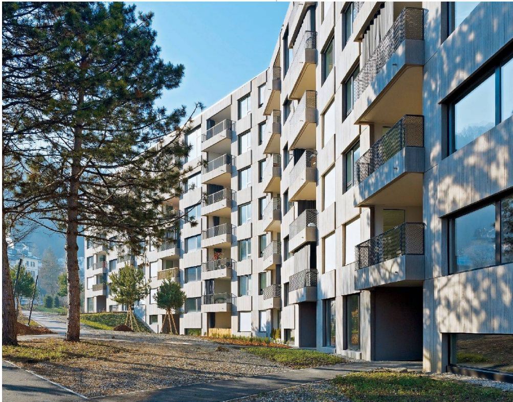
Dank einer leicht verwischten Färbung, einer gerillten Struktur und Vor- und Rücksprüngen wirkt die Fassade des 200 Meter langen Gebäudes nicht zu flächig.
