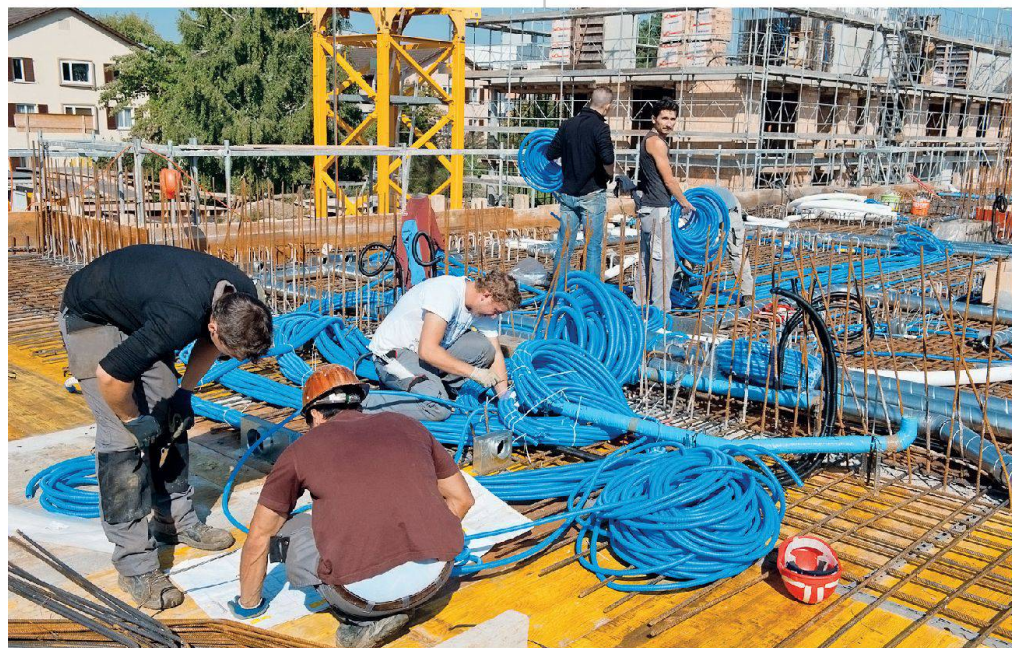
Die Erstellung von Minergiebauten ist technisch komplex. Gute Fachleute und laufende Qualitätssicherung sind gefragt.
