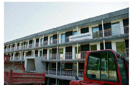
Vor der GV konnten die Teilnehmenden die neue Gewoba- und AWZ-Siedlung Roost in Zug besichtigen.
