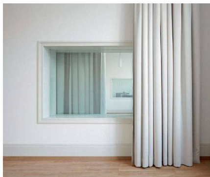
In den schalldämmten Räumen können die Musiker zu jeder Tageszeit üben.
