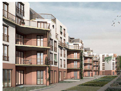
Jüngstes Beispiel für die Stadtzürcher Wohnbaupolitik: Im teuren Quartier Riesbach entstehen in der städtischen Neubausiedlung Hornbach 122 bezahlbare Wohnungen.
