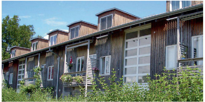
Die Initianten der Schauburg in Hünenberg (ZG) setzten schon in den 1980er-Jahren viele ökologische Postulate in die Tat um. Die Siedlung ist neu im Besitz der Wogeno Luzern.
