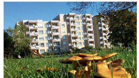
Die «Gartenstadt» der EBG Rapperswil sowie das Baulos 2 von 1976 mit grosszügigem Grünraum.
