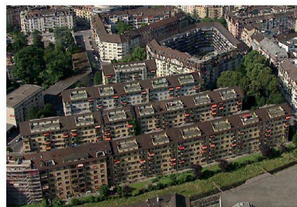
Die heutige Siedlung besteht aus drei Häuserzeilen.
