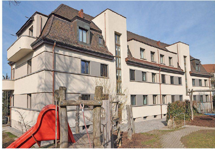
Horizontale Gliederung: Renovierte Eingangsseite.
