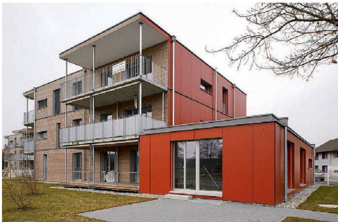
Die Minergiesiedlung Schmidebach verfügt über 25 altersgerechte Wohnungen im Stockwerkeigentum, neun Mietwohnungen und eine Pflegewohnung mit sieben Betten. Sie ist in einen grosszügigen Grünraum eingebettet.
