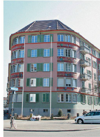
Bei geschützten Bauten ist die Wahl des Renovationsfensters besonders anspruchsvoll (Bild: ABZ-Siedlung Sihlfeld).
