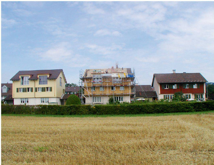
Von links: fertig renoviertes Haus mit Aufstockung – Bauzustand – Haus im Originalzustand.
