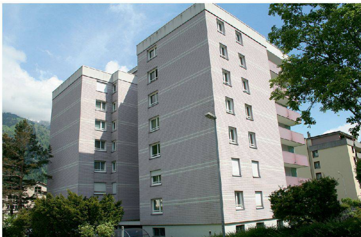
Beim Hochhaus mit Baujahr 1975 wurde in den 1990er-Jahren die Gebäudehülle saniert.
