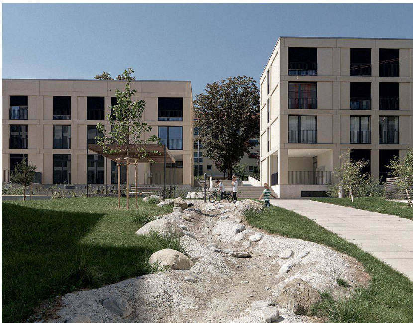
■ Dank einer Bewohnerinitiative kam unter anderem die beliebte Wasserpumpstation für die Kinder zustande.
